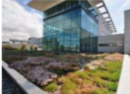
Toiture végétalisée réalisée à partir d'éléments recyclés, Meeting Pot de l'atelier du végétal.
